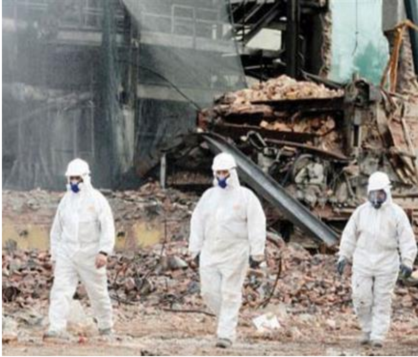
Şekil 5. Asbest söküm işlerinden bir görünüm (Gürbüz, 2017'den).
