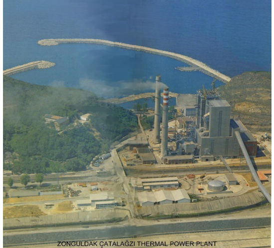
Şekil 2. Çatalağzı B 1-2 Üniteleri 2x150 MW Şlam Yakıtlı Santral.
