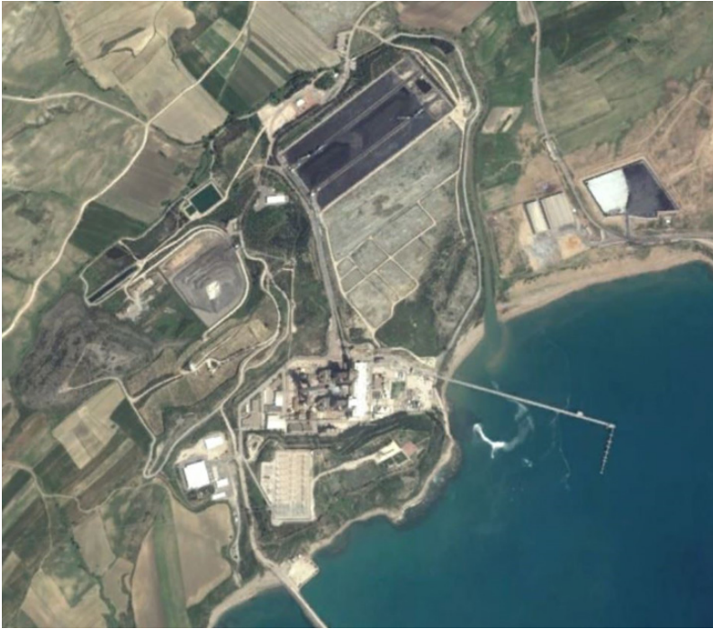
Şekil 12. Türkiye'nin ithal kömüre dayalı ilk termik santrali - 2x600MW İSKEN Yumurtalık Sugözü Santrali genel görünümü.
