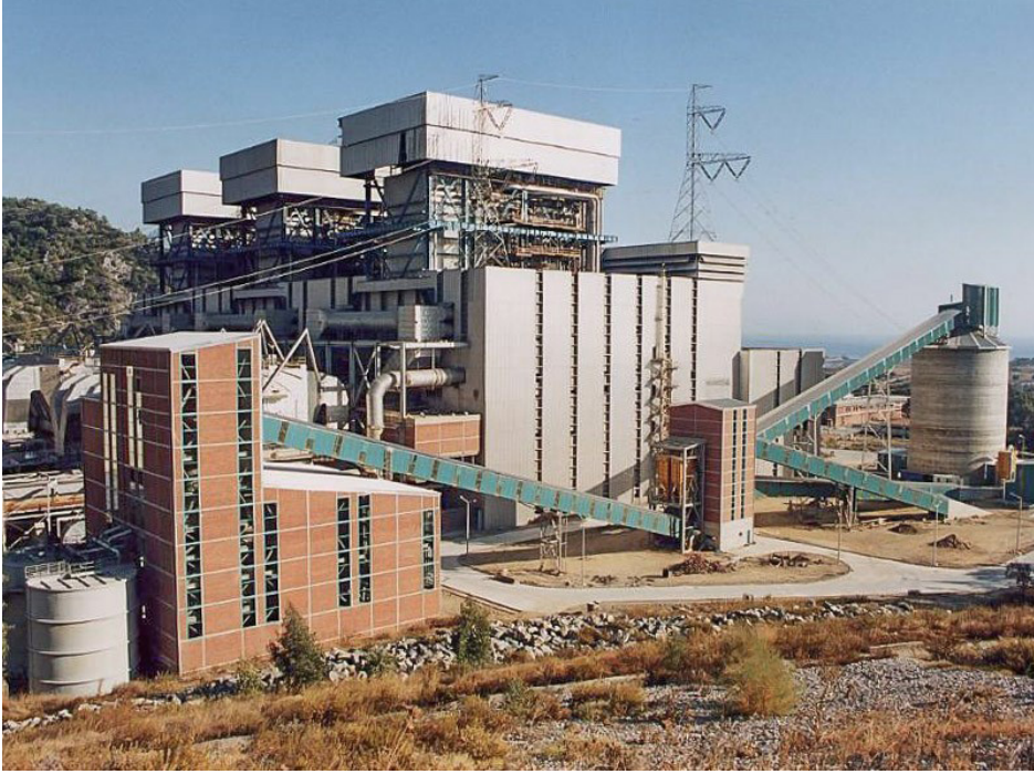
Şekil 24. 3x210 MW Kemerköy Termik Santrali Desülfürizasyon Sistemi Kireç Taşı Silosu.
