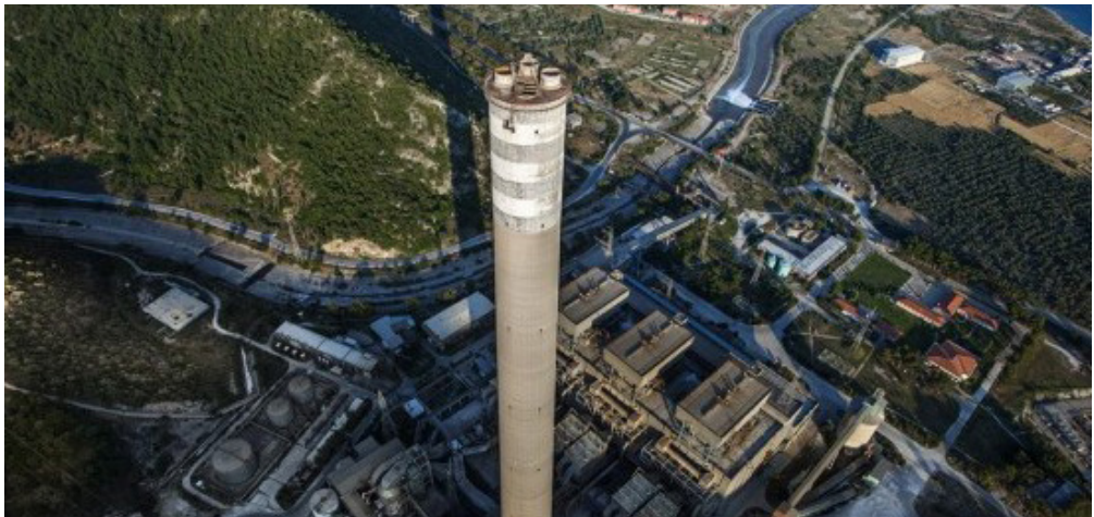
Şekil 21. 3x210 MW Kemerköy Linyit Yakıtlı Termik Santrali.
