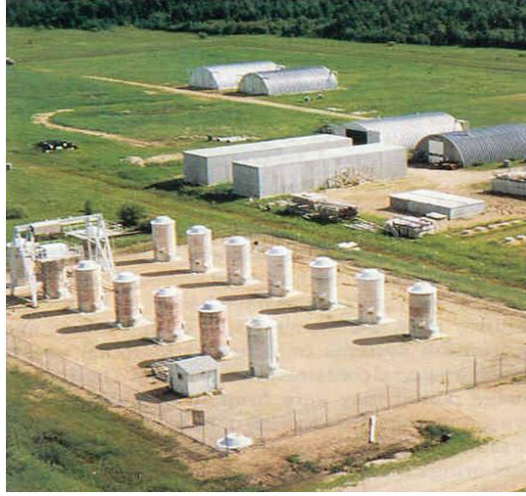
Şekil 3. Kullanılmış yakıtların depolandığı kuru depolama tesisi.
