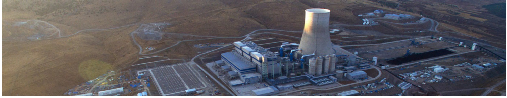
Şekil 14. Enerjisa 3x150 MW Tufanbeyli Akışkan Yataklı, Kömür Yakıtlı Termik Santrali.
