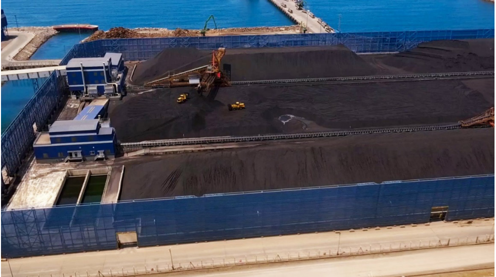
Şekil 18. 2x600 MW Atlas Enerji İskenderun Santralı Kömür Stok Sahası Çevre Koruma Duvarı.
