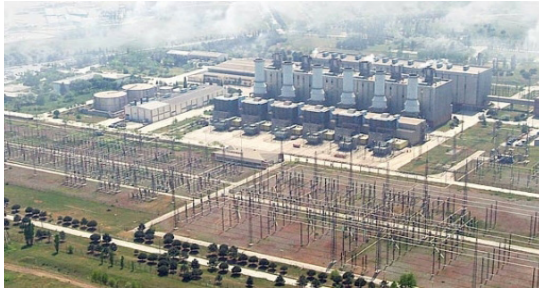
Şekil 10. 1350MW Ambarlı A Doğalgaz Yakıtlı Termik Santrali.
