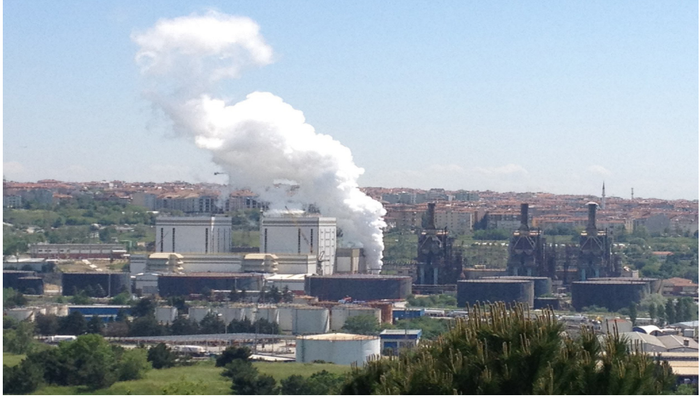
Şekil 16. 820 MW Ambarlı B Santrali (Eski fueloil santrali 4. ve 5. üniteleri yerine yapılan) ve 3x110 MW Eski Ambarlı Fueloil Yakıtlı Termik Santral.
