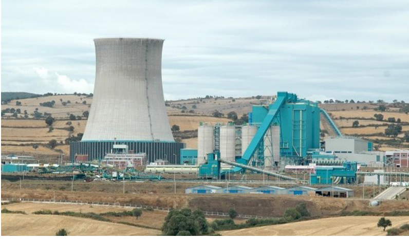
Şekil 4. EÜAŞ 2x160 MW Akışkan Yataklı 18 Mart Çan Santralı. Türkiye'nin ilk akışkan yataklı kazan teknolojisiyle yapılmış santralı.
