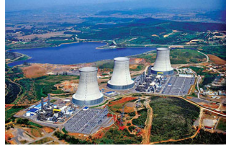
Şekil 11. 2310 MW ENKA Adapazarı ve Gebze Doğalgaz Yakıtlı Termik Santrali.
