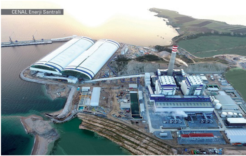
Şekil 19. 2x630 MW Cenal Karabiga ithal kömür yakıtlı santralin kapalı kömür park sahası.
