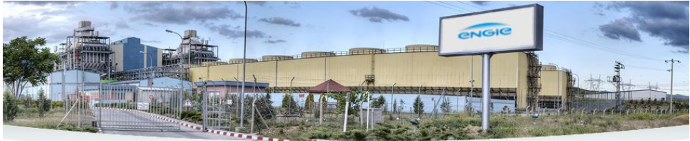
Şekil 28. 770 MW Ankara Baymina Doğalgaz Termik Santrali.
