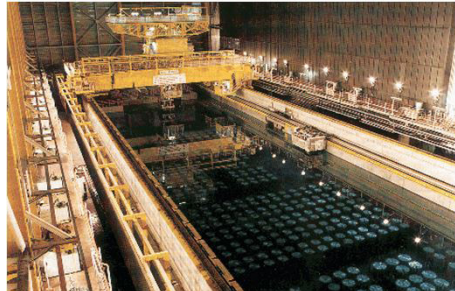
Şekil 2. Kullanılmış yakıt depolama havuzu.
