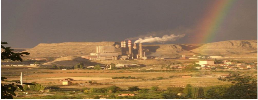
Şekil 6. 4x150 MW Çayırhan Santrali.
