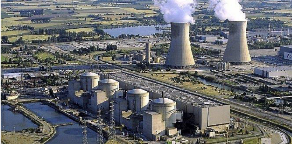
Şekil 5. Uranyum zenginleştirme tesisi, Fransa (MTA, 2017).
