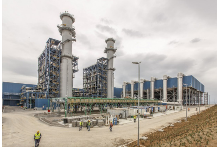
Şekil 22. 870 MW Gebze Dilovası ÜNİT-ANSALDO Doğalgaz Termik Santrali, Hava Soğutmalı Kondenser.
