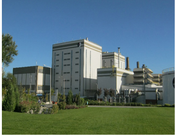
Şekil 3. Ambarlı B Çift Yakıtlı (Doğalgaz ve Fuel Oil) 820 MW Santral.
