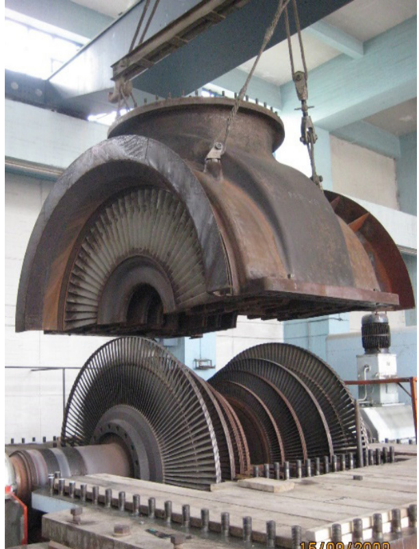
Şekil 9. Ambarlı B Santralı Türbin Montajı.
