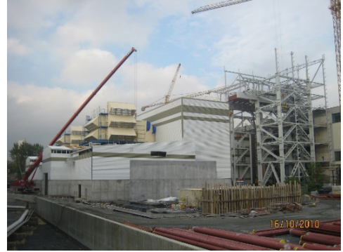
Şekil 30. Ambarlı B Santrali yapım aşamasından iki görünüm, Kazan binası montajı (A) ve Gaz Türbini Montajı (B).
