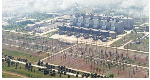
Şekil 8. 1350 MW Ambarlı A Doğalgaz Yakıtlı Termik Santralı.
