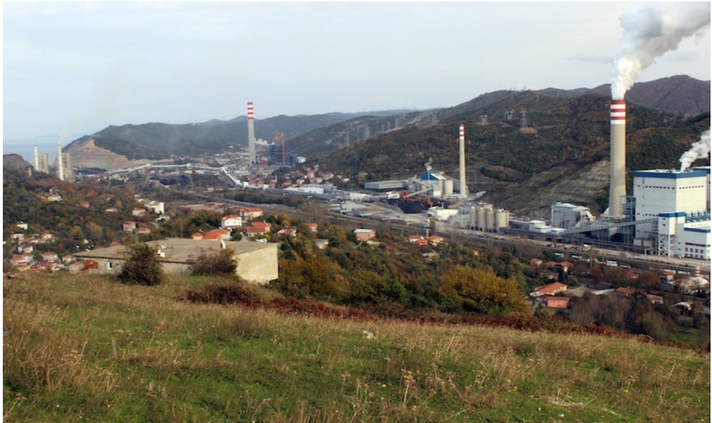
Şekil 2. Zonguldak Çatalağzı Termik Santraller dizisi
